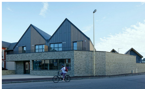
Photo : Atelier Bettinger Desplanques - Prix Palmarès de l'Architecture et de l'Aménagement, catégorie logement, CAUE 27
