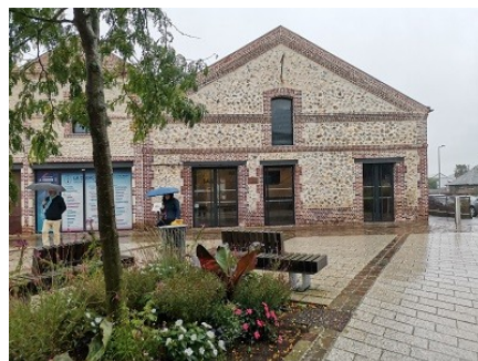
Cidrerie après travaux
