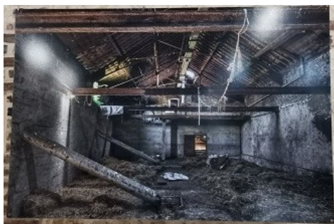
État initial de la cidrerie
