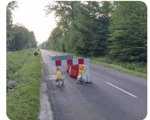
Signalisation d'un danger routier ponctuel à l'aide de dispositifs clignotants et réfléchissants
