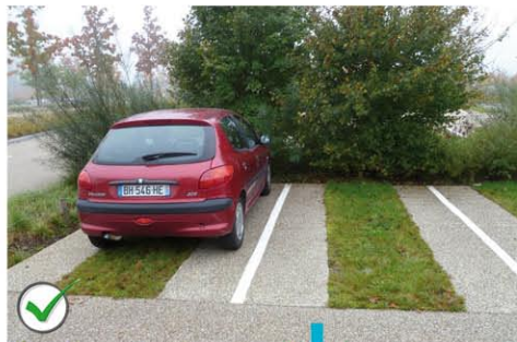
Stationnement mixte : bande de roulement en béton désactivé et surface herbeuse centrale
