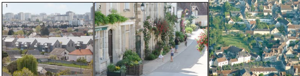
Sources : 1. Image David DESALEUX, photographe ; 2. Image Christophe GAYE, photographe ; 3. Site internet de la commune de Beaulieu-les-Loches, photographie depuis une montgolfière
